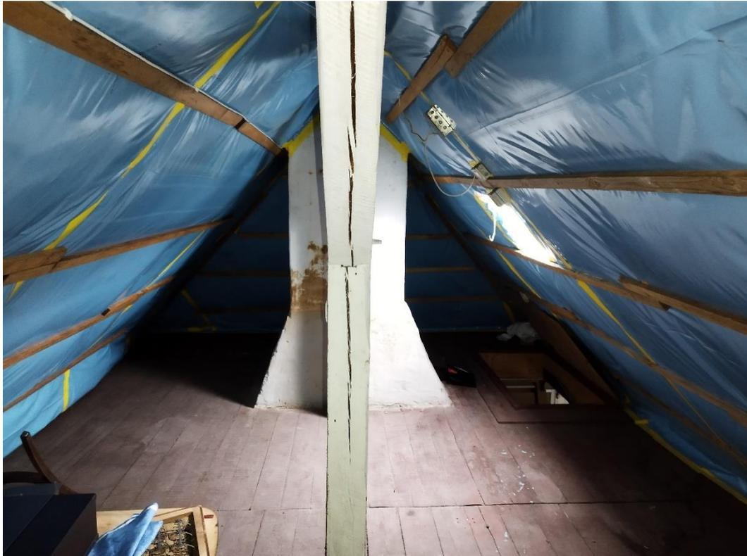
**Abbildung 2-5: Spitzboden der Nummer 33 mit von innen aufgesetzter Sparrendämmung**
