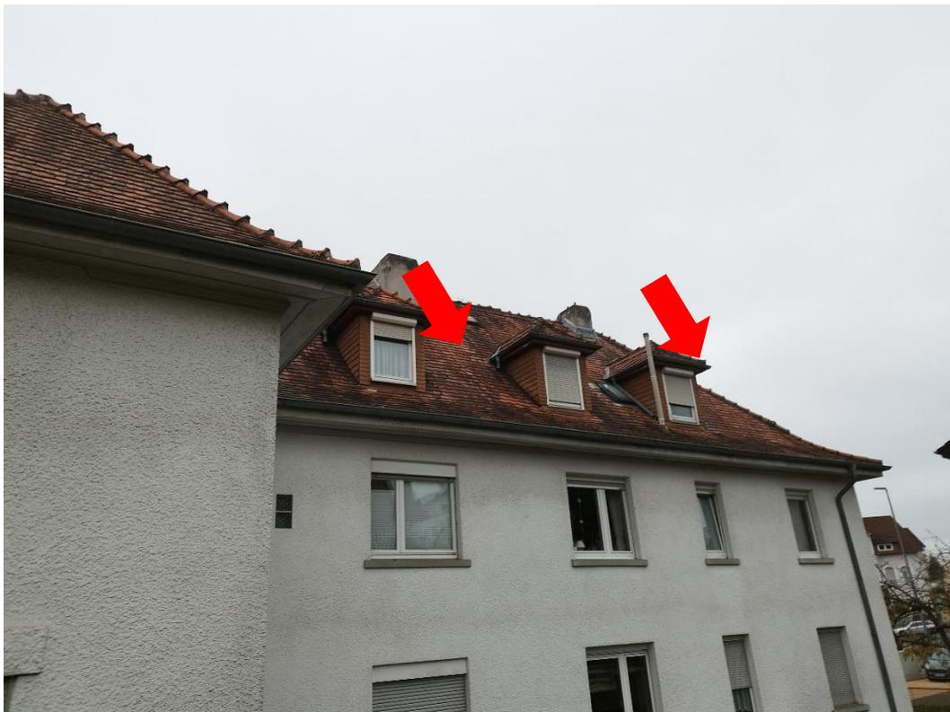
Abbildung 3-4: Defekte und angehobene Ziegel, die einen Zugang zum Dach ermöglichen
