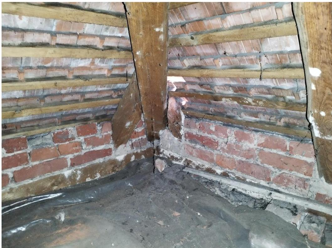
**Abbildung 3-1: Fehlende Ziegel im Dach. Eine Zugangsmöglichkeit für Tiere ist gegeben.**
