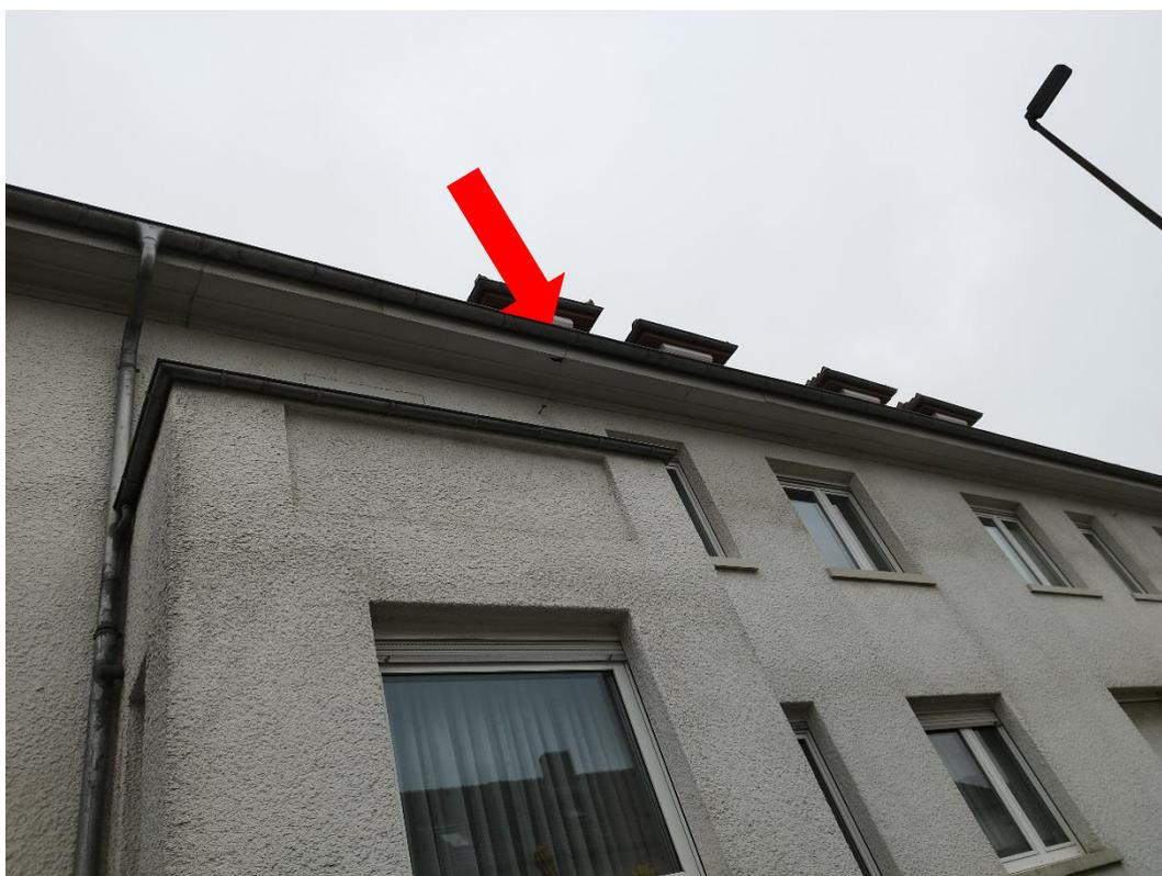
**Abbildung 2-4: Front des Hauses Nummer 33. Defektes Opferbrett ermöglicht Zugang zu Hohlräumen (roter Pfeil).**
